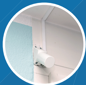
04 Motorgehäuse und Kabelkanal montieren und Kabel einziehen
